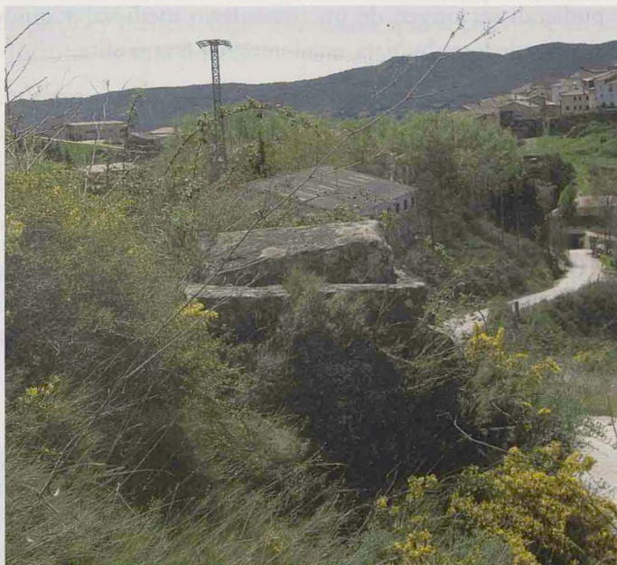
Ermita de San Bartolomé. Arqueta de conducción de aguas por la calzada romana paralela a la ermita.
